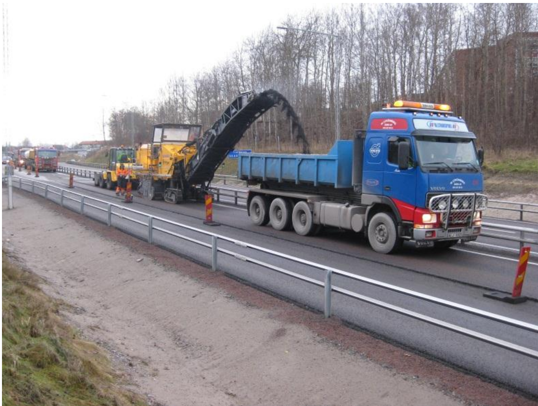
Figur 11. Fräsning av beläggningen på Söderleden (ca 1 månad efter utläggning).
