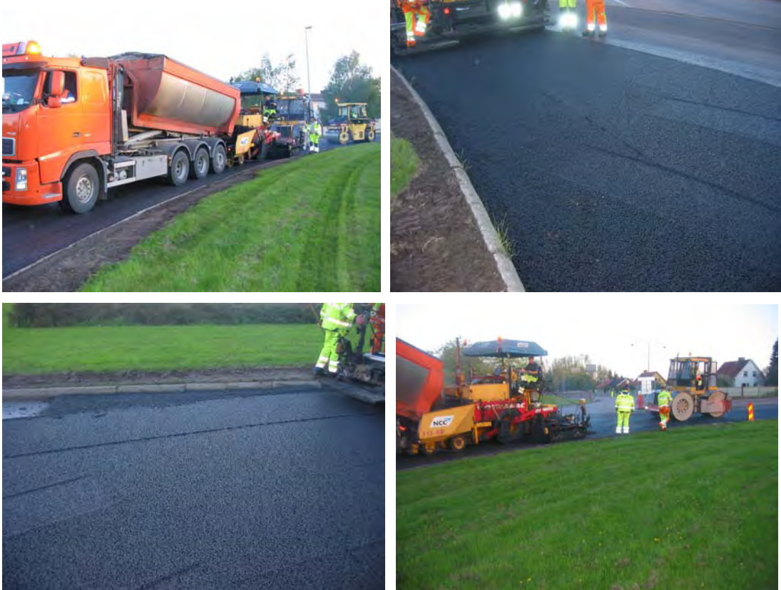
Bild 20 Fotografier från utförandet av ABS 11 med slaggasfalt i cirkulationsplatsen vid Borlänge sommaren 2006.
