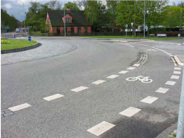
Bild 14 ABT 11 med stålslagg i samtliga sorteringar. Roskilde. Beläggningsen lades år 1984.
