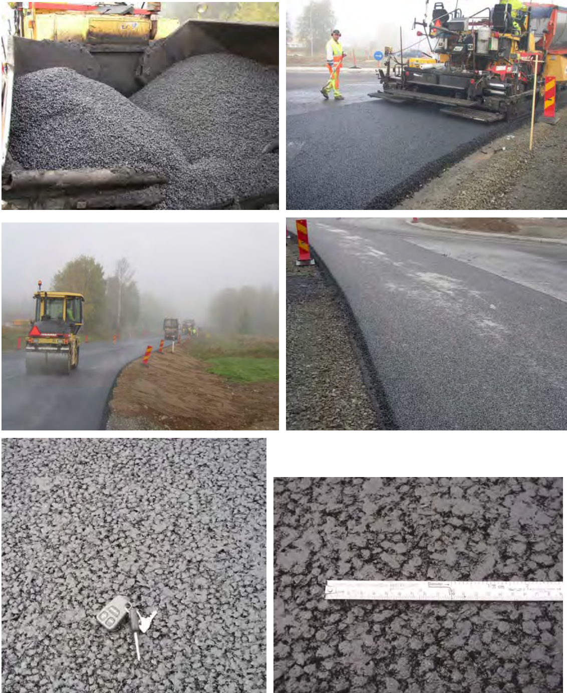
Bild 15 Fotografier från utförandet av ABS 11 med slaggasfalt i cirkulationsplatsen vid Smedjebacken hösten 2005.
