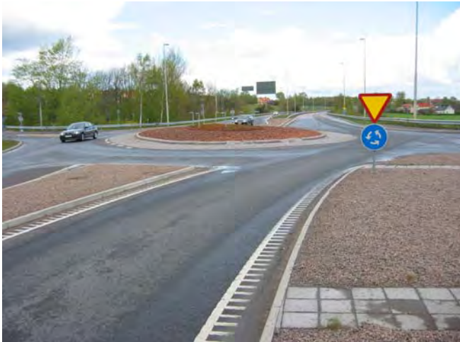
Bild 6 ABS 11, slaggasfalt, lagd 2001, cirkulationsplats i Halmstad, ÅDT 20 000 fordon.
