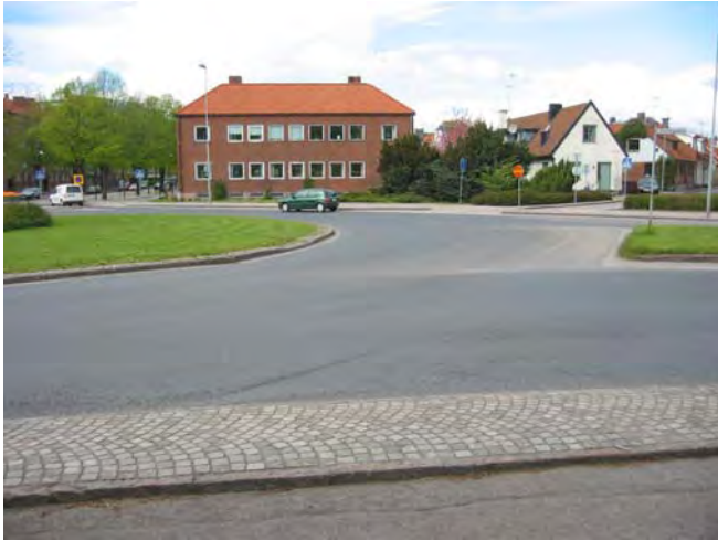
Bild 8 ABS 11, slaggasfalt, lagd 1994, cirkulationsplats i Halmstad, även angränsade vägar hade slaggasfalt, ÅDT 33 000 fordon.
