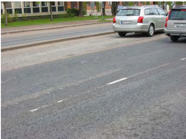
Bild 9 ABS 11, slaggasfalt, lagd 1989, trafikled i Halmstad, ÅDT 30 000 fordon. Beläggningen hade efter 16 år börjat få genomslitningar pga. dubbtrafiken.
