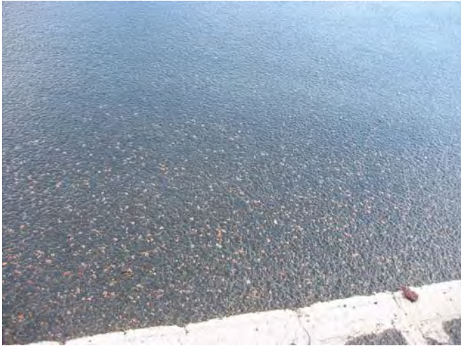
Bild 11 ABS 11, slaggasfalt, lagd 1994, cirkulationsplats i Laholm.
