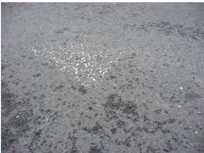
Bild 7 ABS 11, slaggasfalt, lagd 2001, cirkulationsplats i Halmstad, ÅDT 20 000 fordon.
