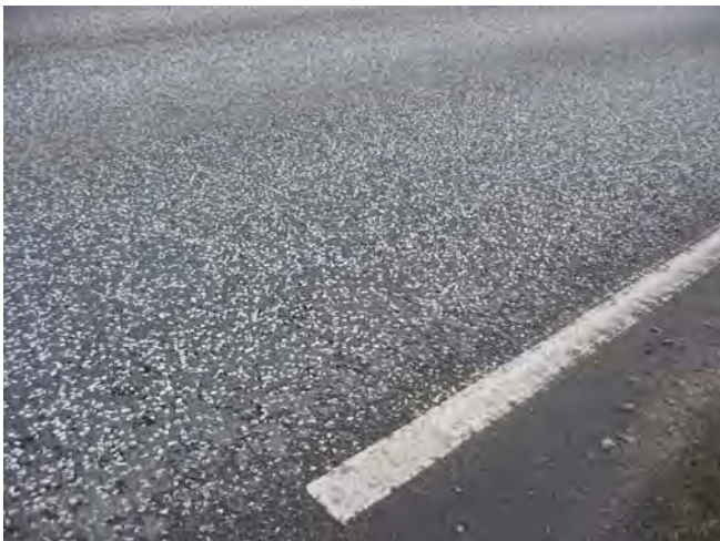
Bild 13 Skelettasfalt 11 med stålslagg i sorteringarna 5–8 och 8–11 mm. Normalt så inblandas i Danmark ljust stenmaterial i slaggasfalten.
