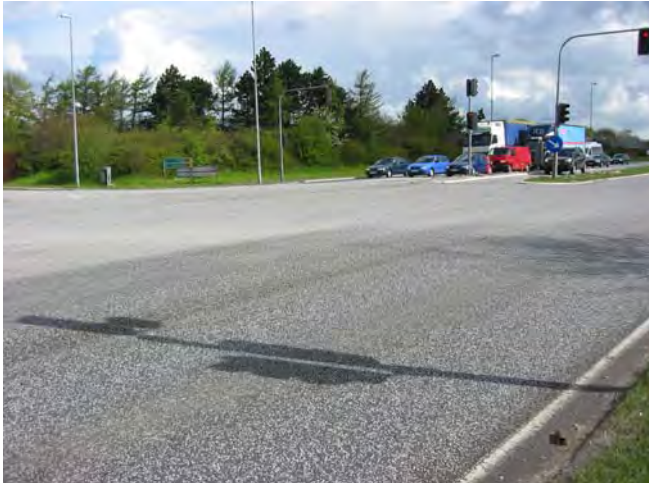
Bild 12 Skelettasfalt 11 med stålslagg i sorteringarna 5–8 och 8–11 mm, trafikled med intensiv trafik utanför Köpenhamn.
