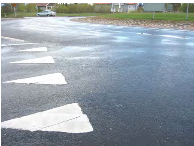
Bild 10 ABS 11, slaggasfalt, lagd 1994, cirkulationsplats i Laholm.
